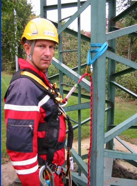
**Die Zwischensicherungen müssen so angebracht werden, dass ein Verrutschen ausgeschlossen ist.**
