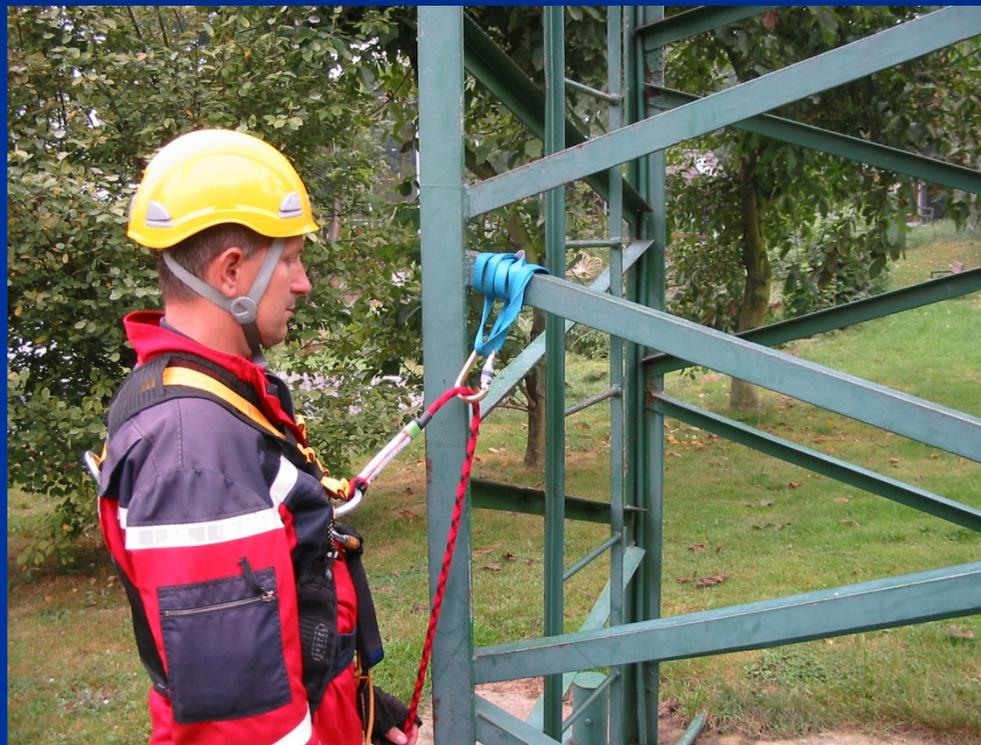
Verrutschen der Zwischensicherung bei Belastung möglich
